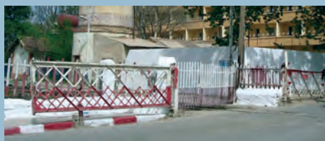
Barrière du passage à niveau
