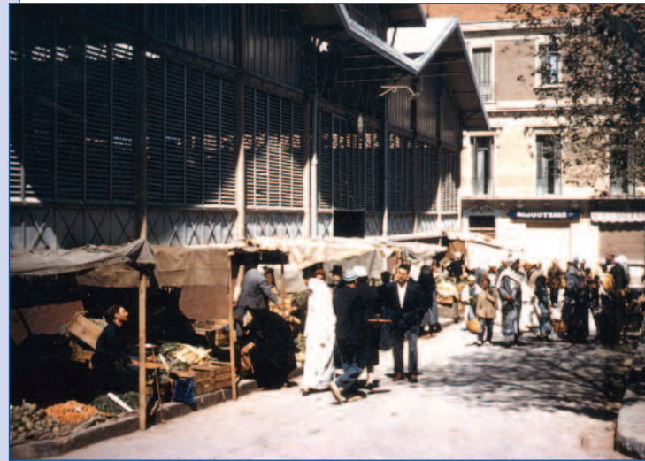
Le marché couvert. Au fond l'immeuble Cazès
